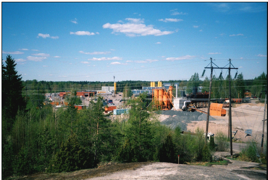
Kuva 13. Lemminkäinen Oyj:n Sammonmäen tehdasalue kuvattuna etelästä.
