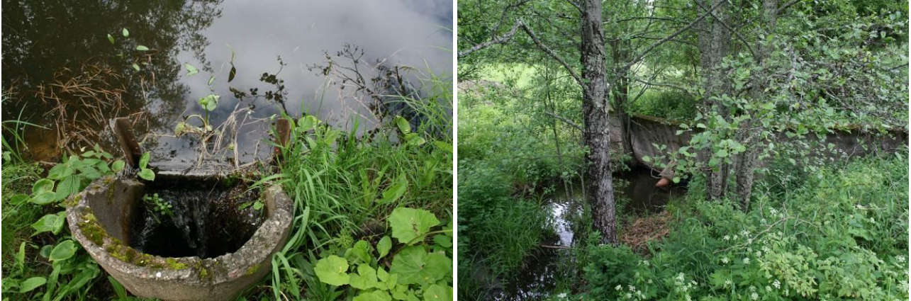
Kuva 44 a ja b. Vesirakenteet ovat elinkaarensa loppuvaiheessa.
