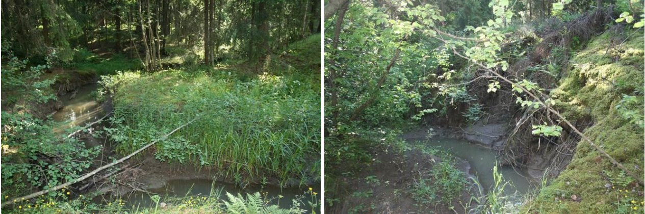
Kuva 50 a ja b. Sedimentaatio ja eroosio ovat uomassa voimakkaita. Hulevesien johtaminen puroon heikentää uoman luonnollista stabiilitettä.
