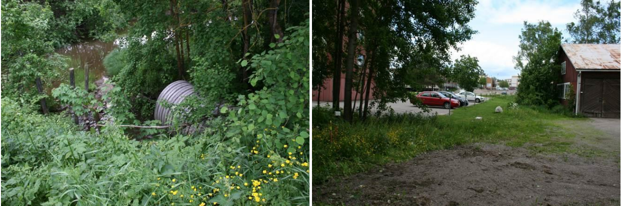
Kuvat 30 a ja b. Färjärinojan loppuosa on putkitettu keskusta-alueen läpi.
