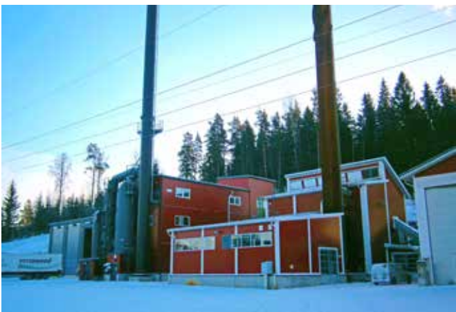
Klaukkalan uuden biolämpölaitoksen polttoaine on kotimaista uusiutuvaa energiaa, jota saadaan laitoksen lähialueilta.
