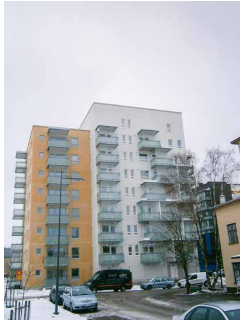
Pajalankurki on jälleen hyvä esimerkki Mestariasuntojen rakentamisesta, energiatehokkaasta ja uusiutuvaa energiaa hyödyntävästä kerrostalosta Järvenpäässä. Kuva: Tapani Hänninen
